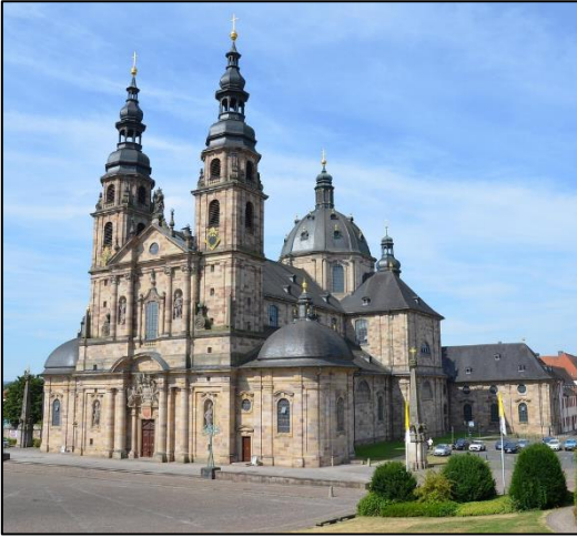
Fulda (Dom): Ostfassade und nördliche Anbauten
